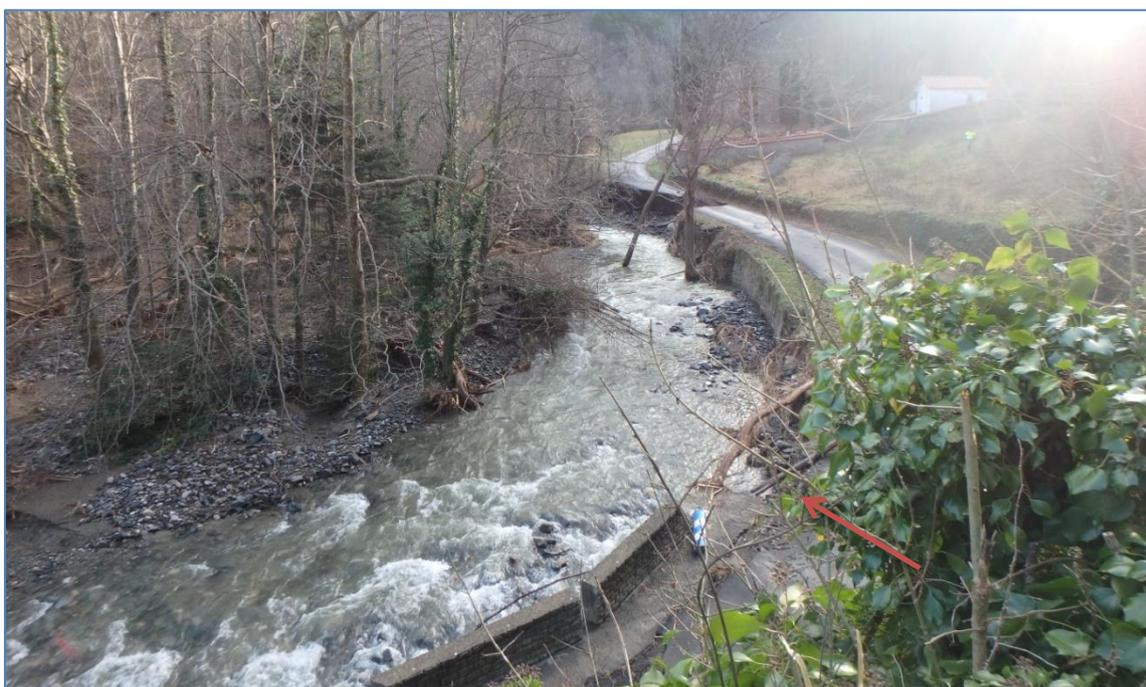
Figure 108: Amont de l'embâcle et parapet effondré
