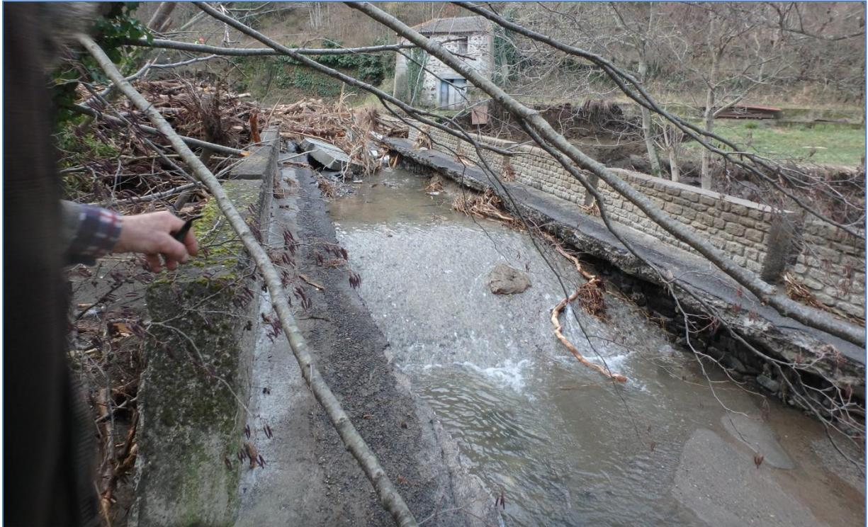
Figure 111: Chaussée du pont complètement détruite
