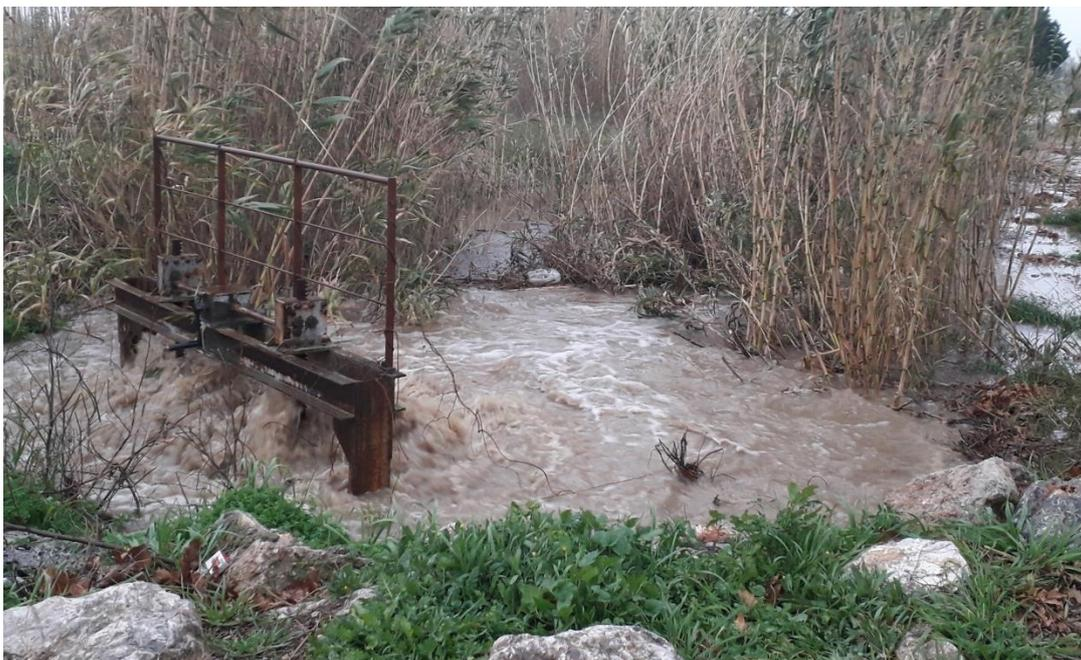
Figure 80: remontée des eaux de l'Agly par l'exutoire du rec de Clair malgré la fermeture de la vanne
