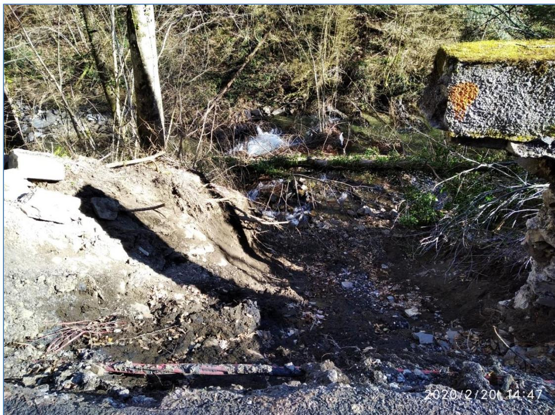
**Figure 103: Glissement de terrain en contrebas de la RD22**
