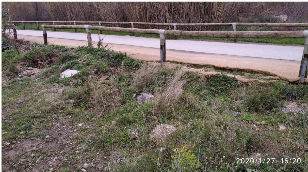
Figure 69: Dommages sur la voie verte suite aux surverses sur le secteur 2
