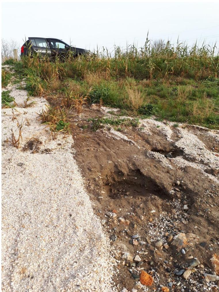
Figure 90: érosion par surverse observée en D004
