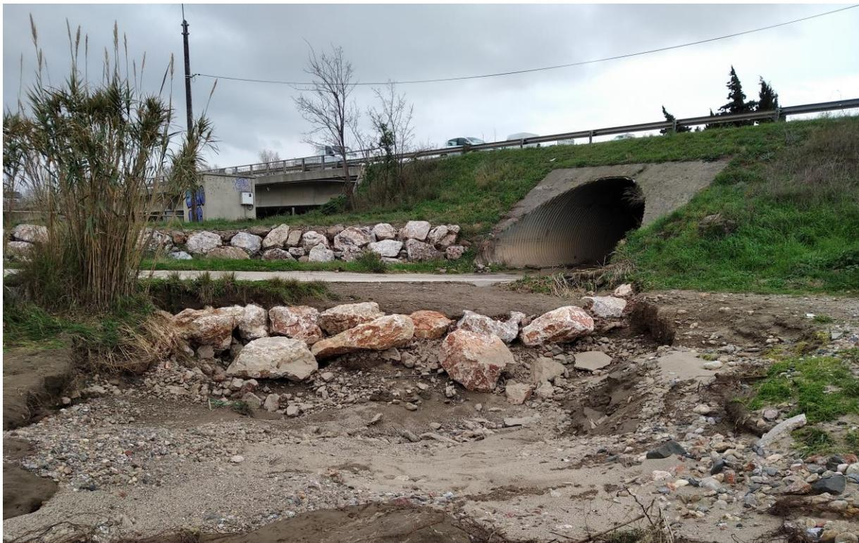
Figure 74: fosse d'érosion à la sortie du tunnel sous la RD900 en rive droite
