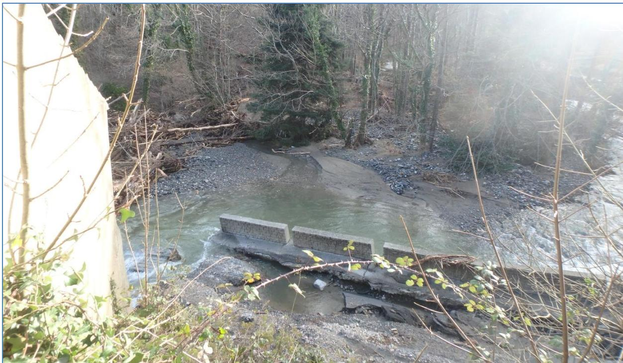
Figure 109: Vue de l'amont du pont et début de l'embâcle, route détruite
