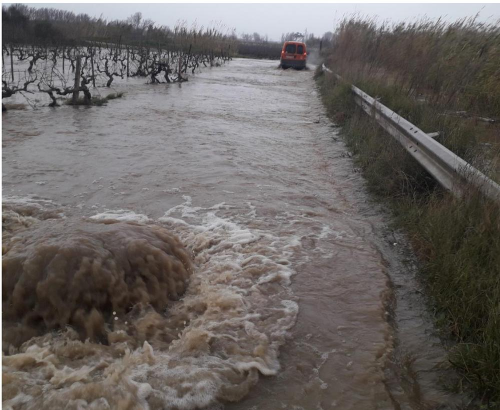
Figure 82: résurgence par tampons du réseau pluvial du centre commercial au niveau de l'accès à la voie verte
