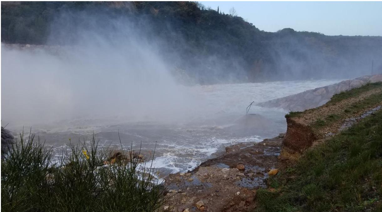
Figure 36: Dommages en contrebas des déversoirs du barrage
