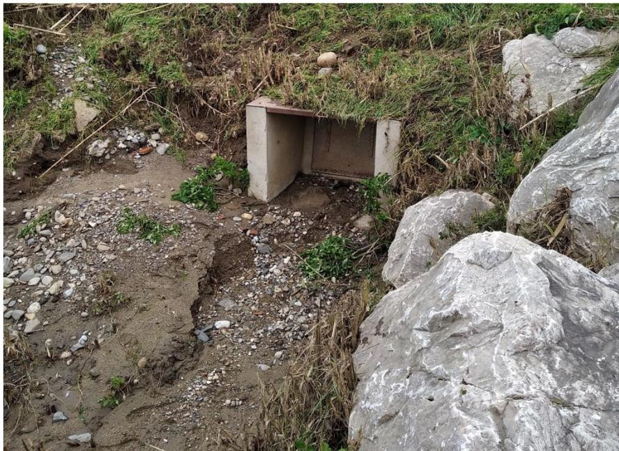
Figure 85: exutoire du réseau pluvial du lotissement l'Eden
