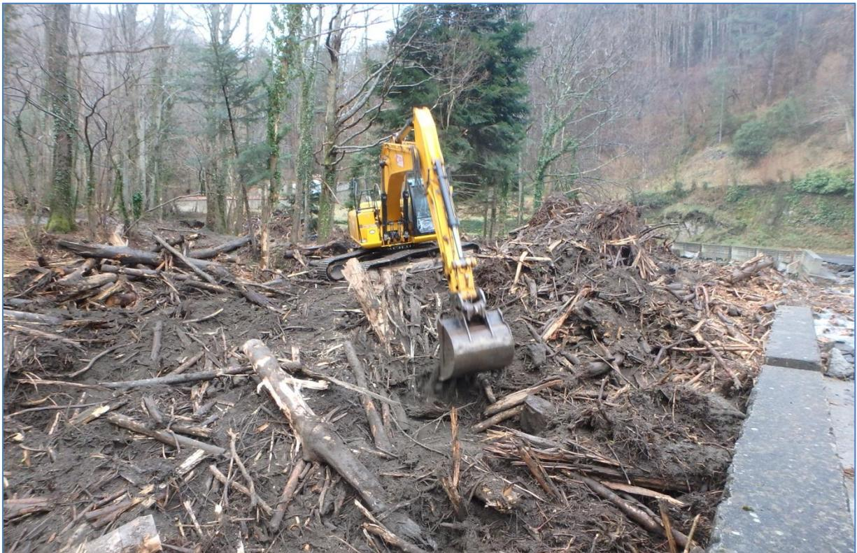
Figure 119: Pelle mécanique en cours d'enlèvement de l'embâcle
