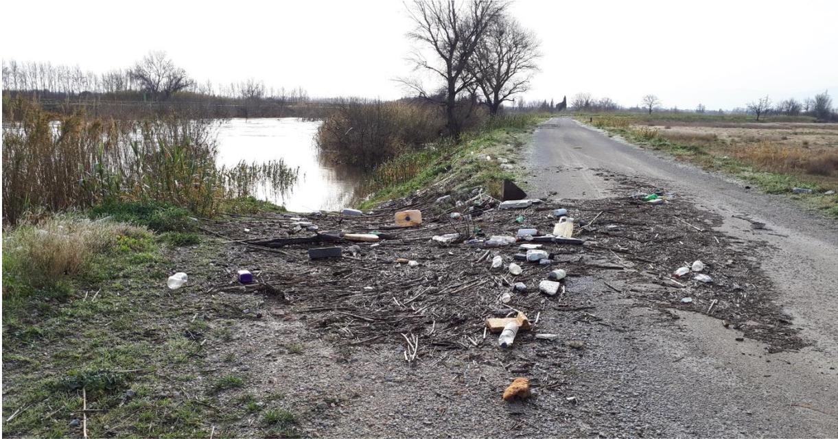
Figure 91: dépôts témoignant d'une surverse en D008
