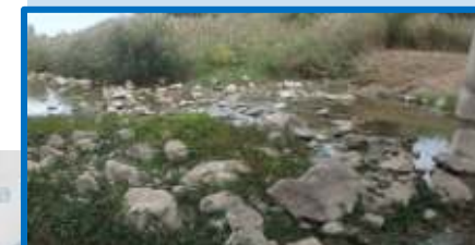
A5 : en aval du pont D81
