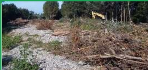
Les travaux 2020-2021 – p.3
